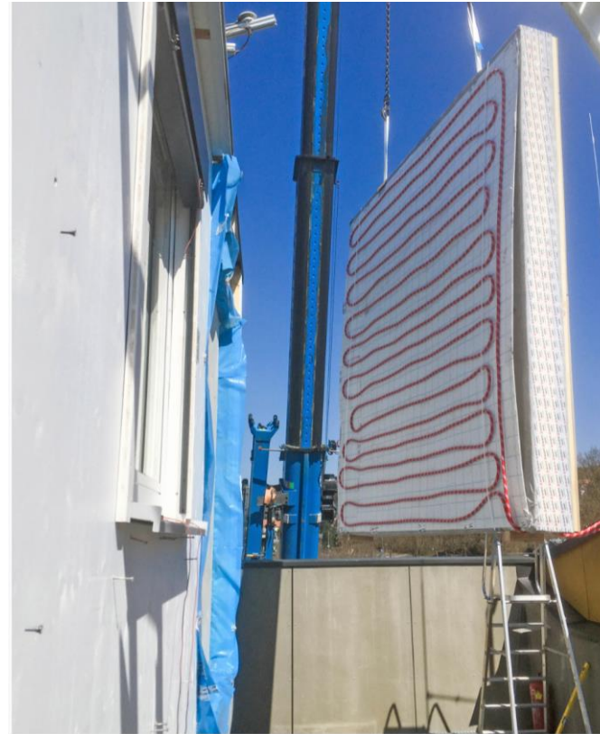
Einbau des Fassadenprototyps aus „MultiTab“ in die Fassadenprüfanrichtung bei AEE Intec Foto: AEE Intec
